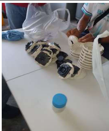
แยกชิ้นส่วน Smoke detector เพื่อทำความสะอาด
