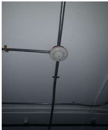
สภาพ Heat detector ชั่วครู่ Bypass ออกจากระบบไว้
