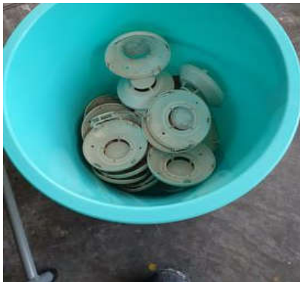
แยกชิ้นส่วน Smoke detector เพื่อทำความสะอาด
