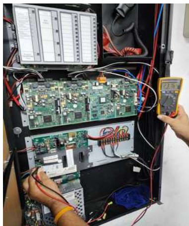
ตรวจสอบ วัดค่า Main Power Supply
