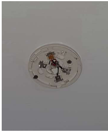
สภาพ Base Smoke detector ชั่วครู่เป็นสนิม
