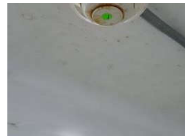
Heat detector สภาพสนิม แต่ยังสามารถใช้งานได้
