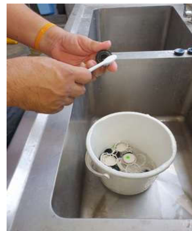
ล้างทำความสะอาดชิ้นส่วน Smoke detector
