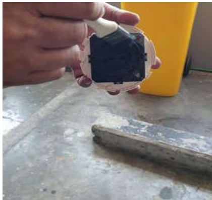
ทำความสะอาด Smoke detector
