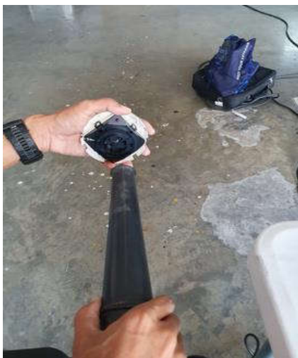
เป่าทำความสะอาด Smoke detector
