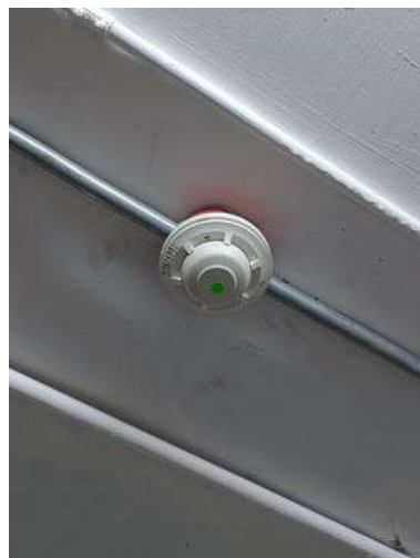
Heat detector ชนิด Fix Temp.
