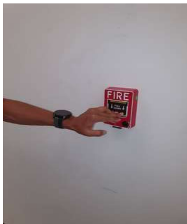
ทดสอบการทำงาน Manual pull down
