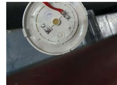
สภาพ Heat detector ชำรุด Bypass ออกจากระบบไว้
