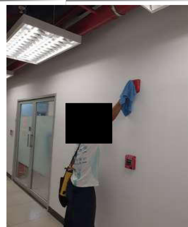
ทำความสะอาด ชุด Horn with Strobe
