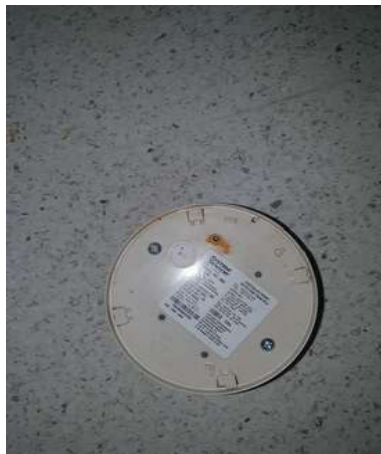
สภาพ Smoke detector ชั่วครู่เป็นคราบสนิม
